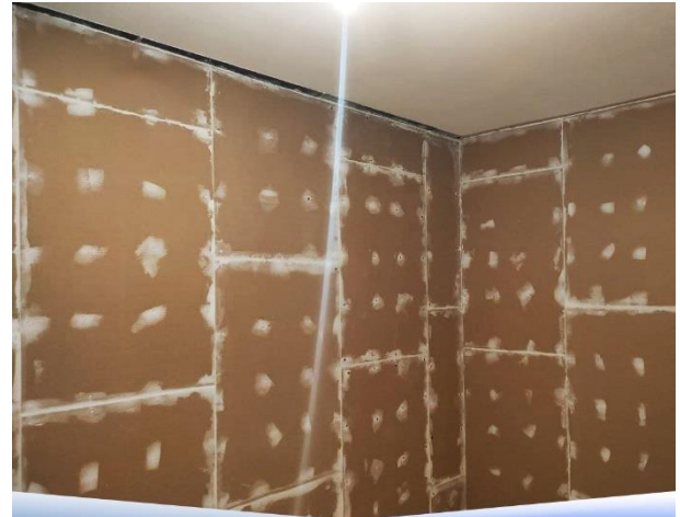
ШУМОИЗОЛЯЦИЯ СТЕН И ПЕРЕГОРОДОК. БЕСКАРКАСНАЯ УСИЛЕННАЯ СХЕМА. СНИЖЕНИЕ ШУМА ДО 55-65%! Звукоизоляционные панели ТИС 14
