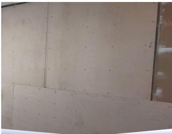
ШУМОИЗОЛЯЦИЯ СТЕН И ПЕРЕГОРОДОК. БЕСКАРКАСНАЯ УСИЛЕННАЯ СХЕМА. СНИЖЕНИЕ ШУМА ДО 55-65%! Монтаж ГВЛ.
