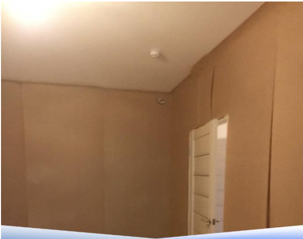
ШУМОИЗОЛЯЦИЯ СТЕН И ПЕРЕГОРОДОК. БЕСКАРКАСНАЯ СХЕМА. СНИЖЕНИЕ ШУМА ДО 50-60%! Монтаж демпфирующей подложки на стены
