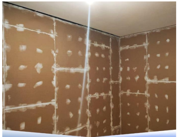
ШУМОИЗОЛЯЦИЯ СТЕН И ПЕРЕГОРОДОК. БЕСКАРКАСНАЯ СХЕМА. СНИЖЕНИЕ ШУМА ДО 50-60%! Звукоизоляционные панели ТИС 14
