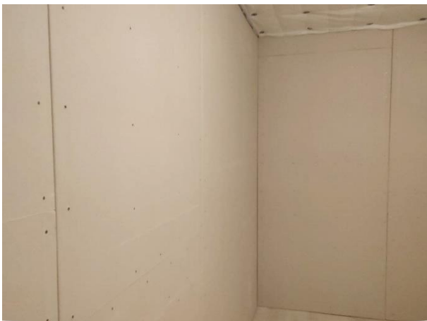
ШУМОИЗОЛЯЦИЯ СТЕН И ПЕРЕГОРОДОК. БЕСКАРКАСНАЯ СХЕМА. СНИЖЕНИЕ ШУМА ДО 50-60%! Монтаж ГКЛ. Финишный слой.
